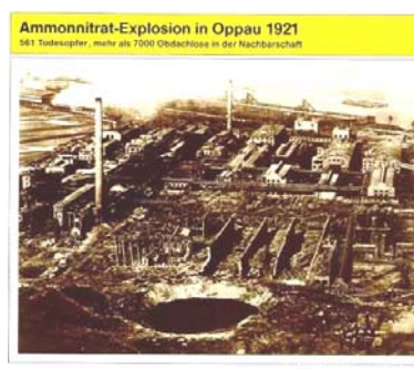
Abb. 2: Historische Luftbildaufnahme der BASF nach einem Werksunfall
